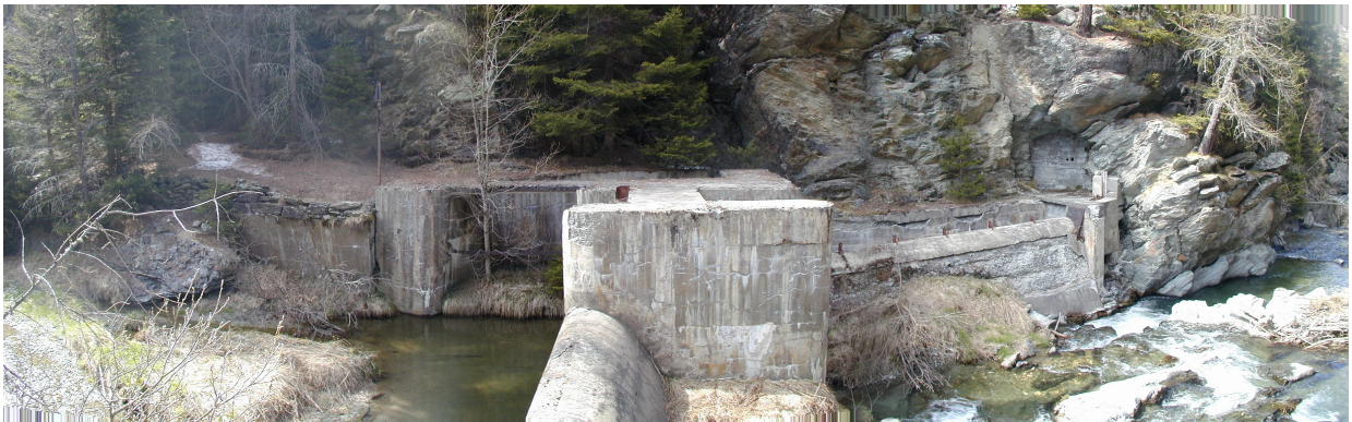
Foto 1 - Opera di presa – traversa in alveo (A)
