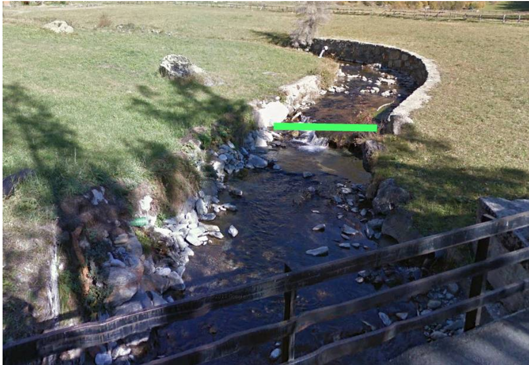
Foto 11 - Zona opera di presa
