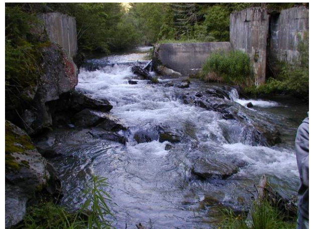
Foto 2 - Traversa in alveo vista da valle
