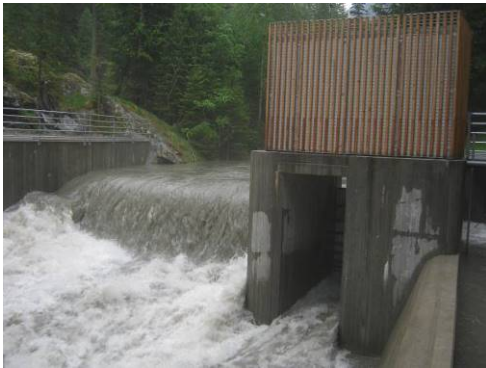
Foto 6 - Opera di presa
