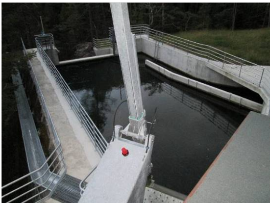
Foto 7 - Vasca di carico
