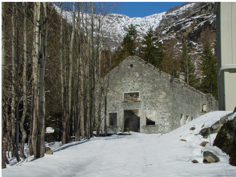
Foto 5- Edificio di centrale (C)
